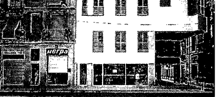
H7 Josep Llinàs Apartment building in El Raval Barcelona 1992-1995
